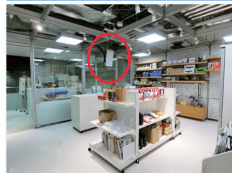
DX推進センター内の3カ所に、直進性の高い28GHz帯を用いたローカル5Gの通信施設を整備しました。
