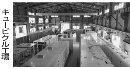
キュービクル工場
